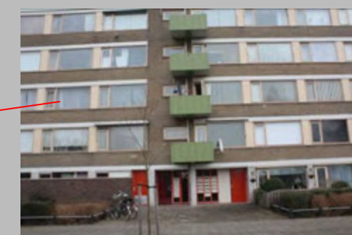
Oude beleggerswoning (4 blokken)
